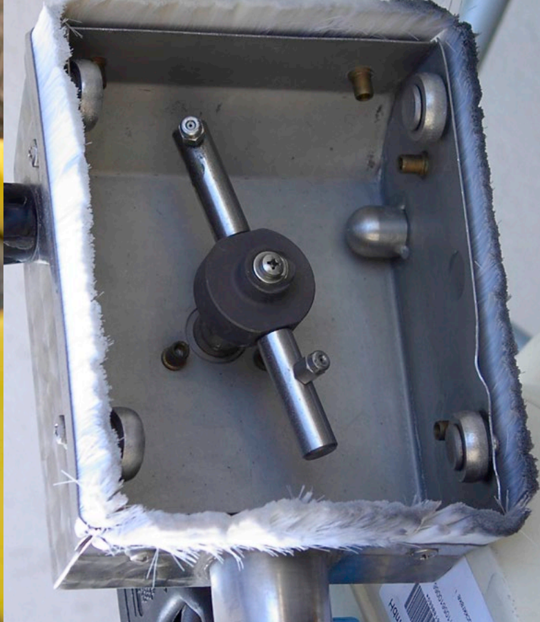
Die Hochdruckkrake: Rußentfernung und -absaugung ohne Chemie
