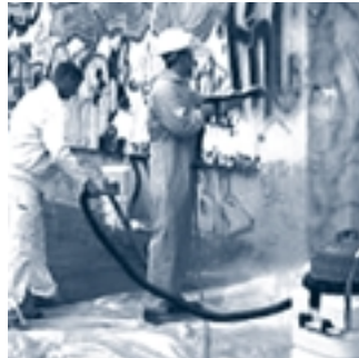
Das Heißwasser- Hochdruckverfahren.
